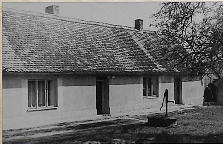
Obecní důmek v Litošovicích po adaptaci (foto 1976)
